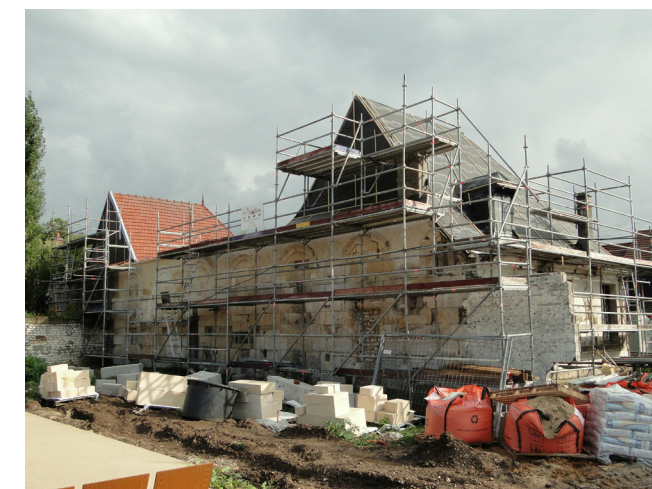
Travaux de restauration sur le mur du grand cloître en 2015
