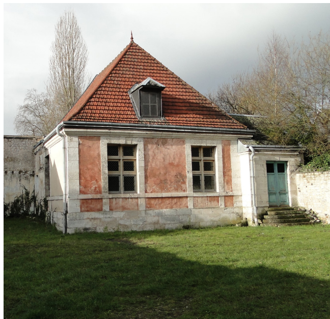
La cellule n°5 de la galerie Est
